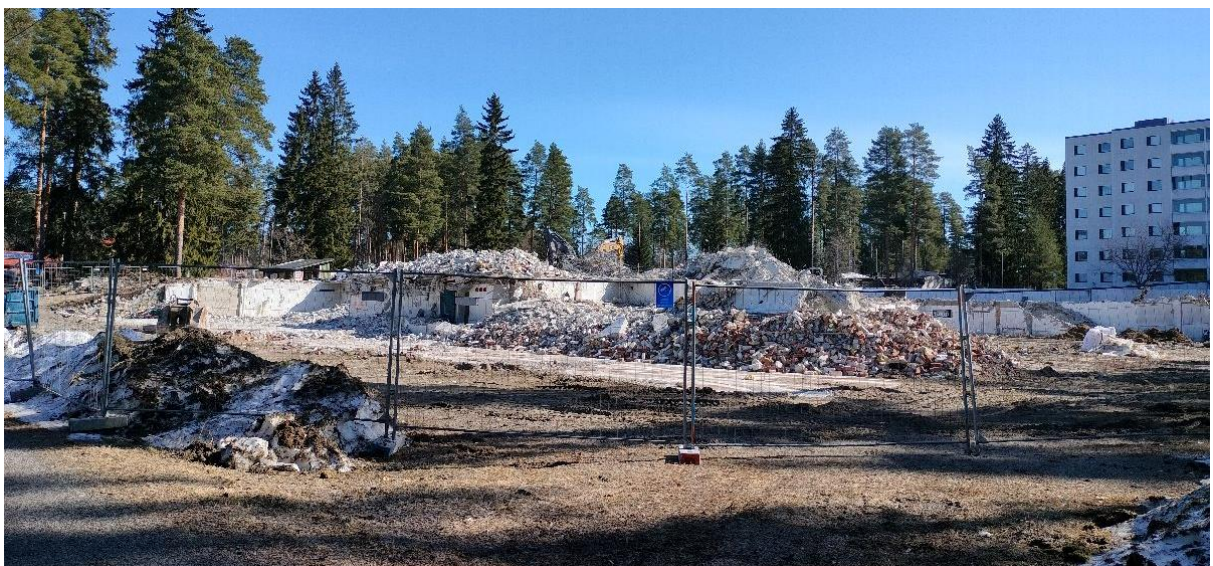
Kuva 3. Siekkilän koulurakennus on lähes purettu.
